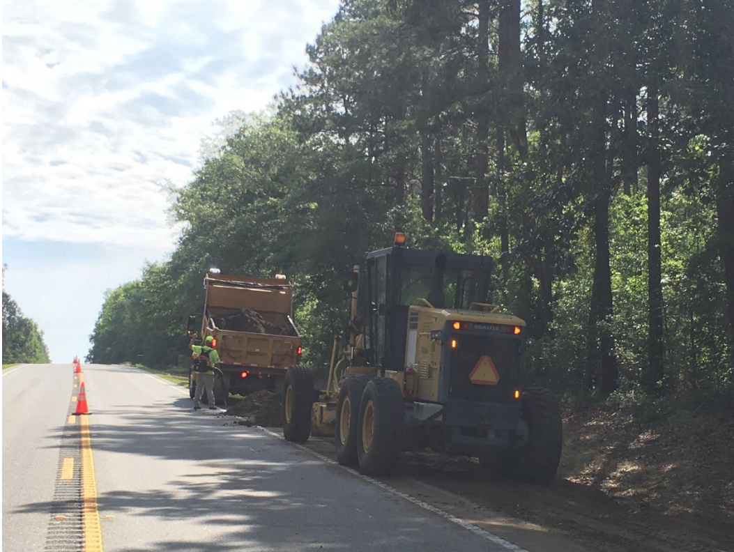
Clean & Restore Ditches
